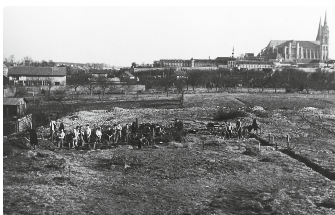
Début des travaux de construction sur le plateau de Rechèvres, en vue de l'implantation d'une église et de la future Cité paroissiale, 1951.
