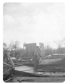
Reconstruction de la chapelle en bois après passage de la tempête, en mars 1951.
