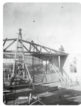
Construction de la chapelle-baraque, provenant de l'ancien camp militaire du Coudray, qui servira d'église provisoire, février/mars 1951.
