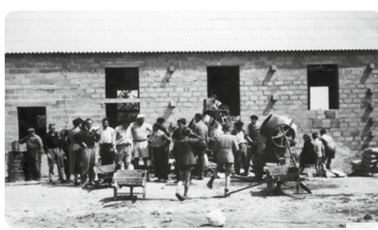
La toiture est installée, mai 1954.
