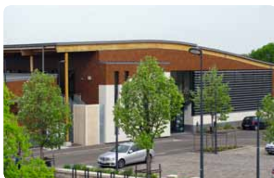
La nouvelle Maison pour Tous de Rechèvres, inaugurée le 14 septembre 2012. Le nouvel édifice porte le nom de la Cité, l'ancienne salle paroissiale cédée dans les années 50 à la ville de Chartres pour financer la construction de la nouvelle église.
