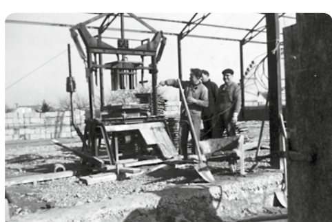
Moule pour la fabrication des parpaings.
