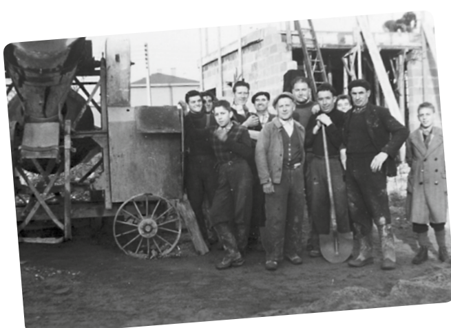
Les Castors posent pour la photo devant le chantier déjà bien avancé.
