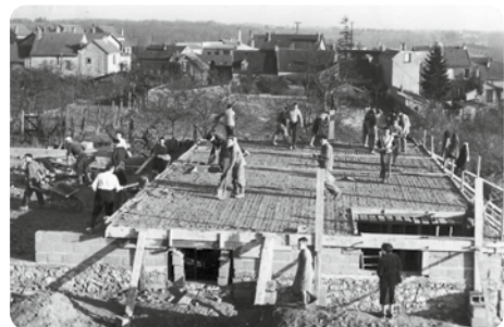
Coulage de la dalle de béton.
