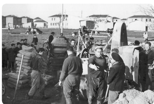
Préparation du ciment pour la fabrication des parpaings, 1953. Monsieur Cotelle, l'un des chefs de chantier, en discussion avec un bénévole. En arrière-plan, le Père Rabel, curé de Rechèvres, reconnaissable à son chapeau. Au fond, les maisons du nouveau quartier de Rechèvres avec le terrain où sera construite plus tard l'église Saint-Jean-Baptiste.
